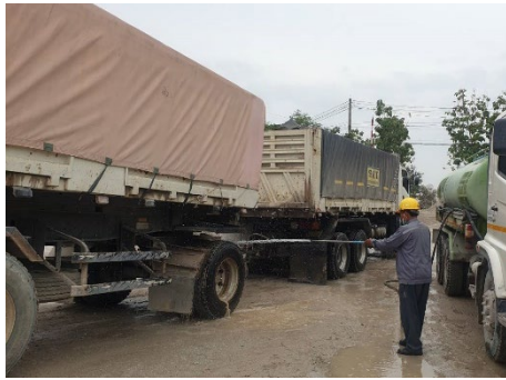
รูปที่ 2-16: การล้างล้อรถบรรทุก
