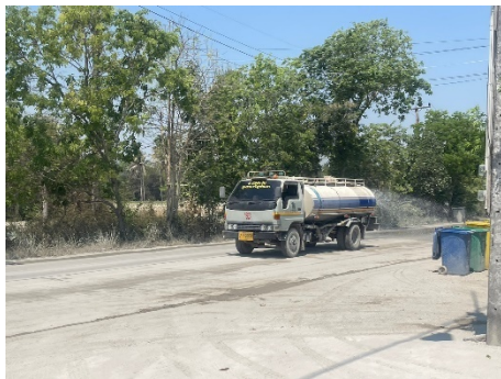
รูปที่ 2-11: การฉีดพรมน้ำบริเวณเส้นทางขนส่งแร่
