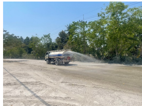
รูปที่ 2-11: การฉีดพรมน้ำบริเวณเส้นทางขนส่งแร่
